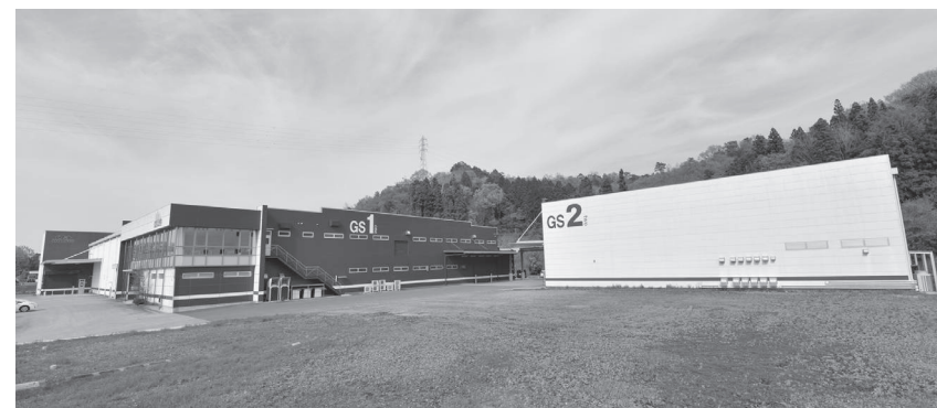
GOOD SPEEDの外観 (左が輪転機と製本ラインが稼働するGS1棟、右がオフセット枚葉機が稼働するGS2棟)。環境に配慮したソーラー発電システムを導入。
